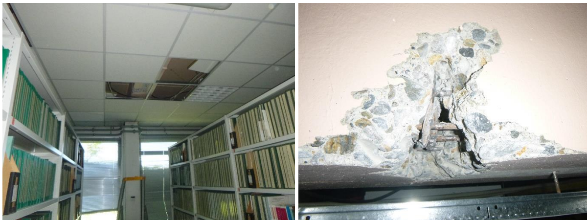
Visualisation du sondage destructif réalisé – S4.1
