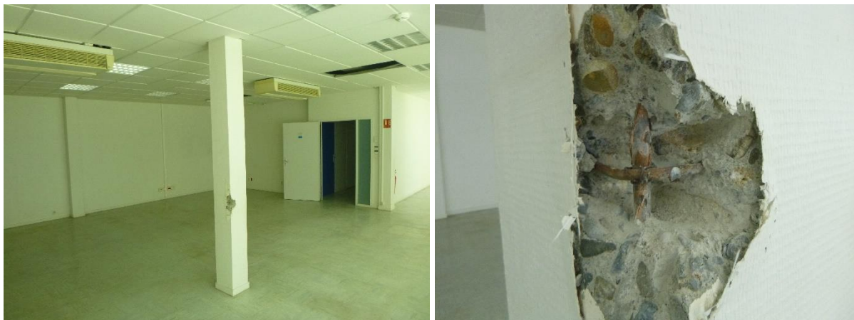
Visualisation du sondage destructif réalisé – S2.1
