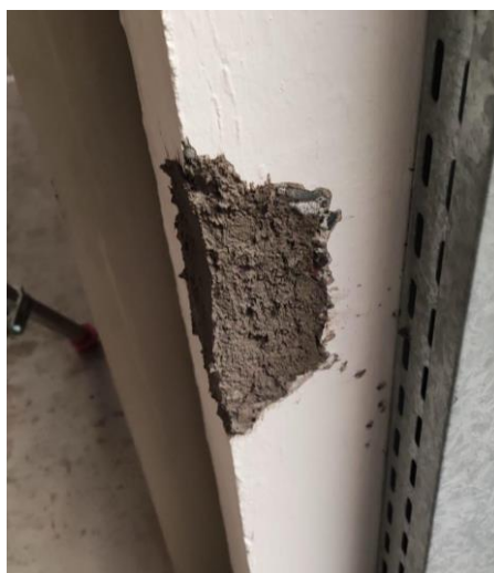
Visualisation du sondage destructif réalisé – S1.1
