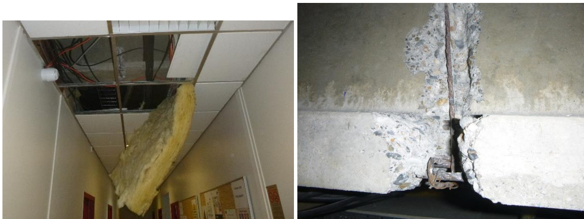
Visualisation du sondage destructif réalisé – S1.3
