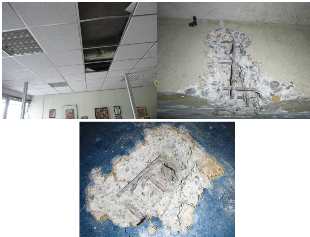
Visualisation du sondage destructif réalisé – S3.2 / S3.3
