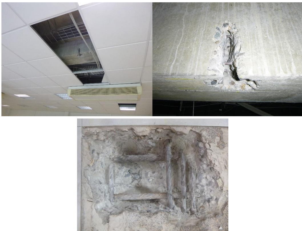
Visualisation du sondage destructif réalisé – S2.2 / 2.4
